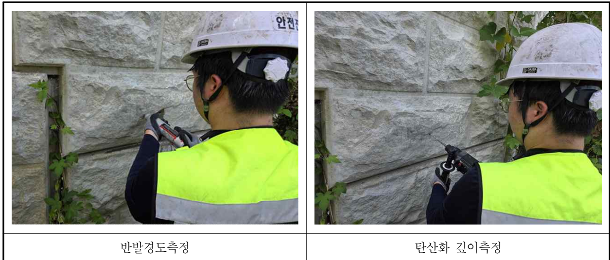
【사진 8.4.1】 재료시험 조사 전경
