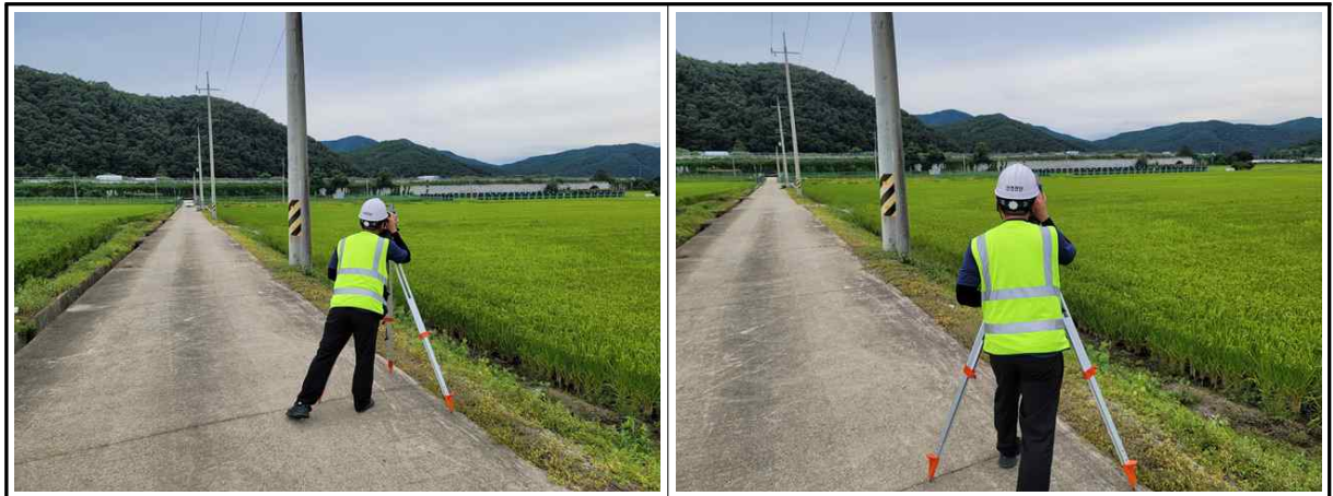
【사진 8.4.2】 측량작업 전경
